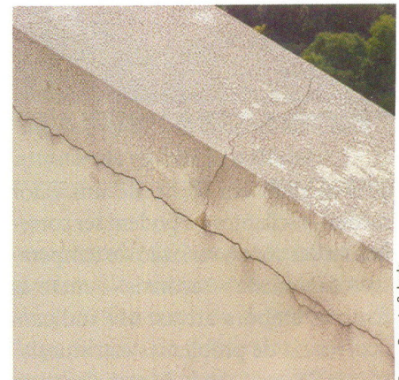
Destacamento da argamassa de revestimento por movimentação térmica
