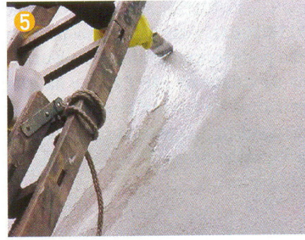
Aplicação de impermeabilizante acrílico
