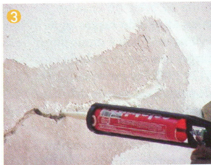
Aplicação de selante acrílico
