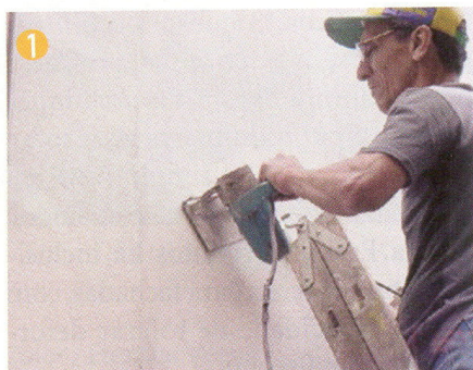
Abertura de sulco sobre a fissura
