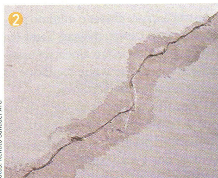
Remoção do acabamento da parede
