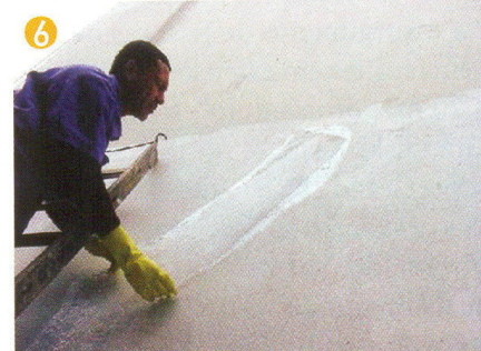
Segunda demão de impermeabilizante estruturado em tela de poliéster
