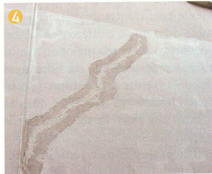
Secagem da fissura selada
